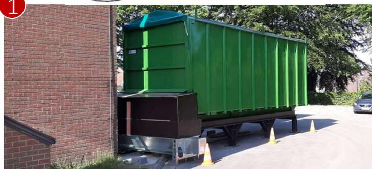
1 Les plaquettes de bois (copeaux de bois) sont stockées dans un container de 40 m<sup>3</sup> situé à l'extérieur
