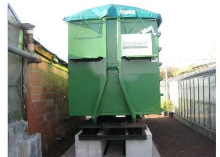
**1** Les plaquettes (ou copeaux de bois) sont stockées dans un container de 40 m<sup>3</sup> (pour avoir l'équivalent de 4 000 litres de mazout)
