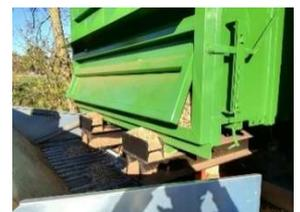
**2** Les plaquettes sont acheminées du container « silo » vers un autre container de stock tampon. Ce stock tampon alimente les chaudières, et permet d'attendre le remplacement du container « silo ».
