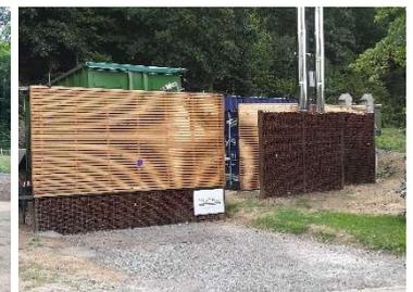
**1** Les plaquettes (ou copeaux de bois) sont stockées dans un container de 40 m<sup>3</sup>. Ce container « silo » mobile est remplacé dès qu'il est vide par un autre container « silo » rempli.
