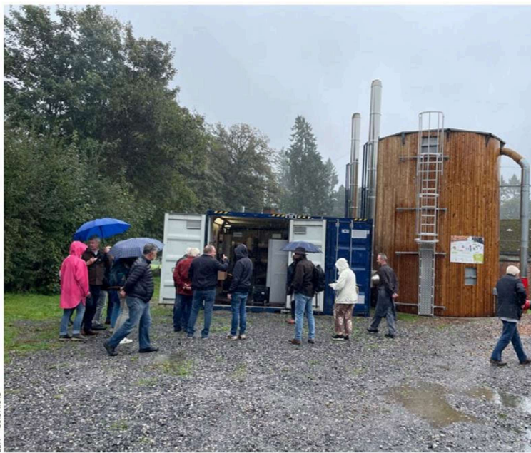
Quatre anciennes chaudières à mazout ont été remplacées par deux chaudières bois.
